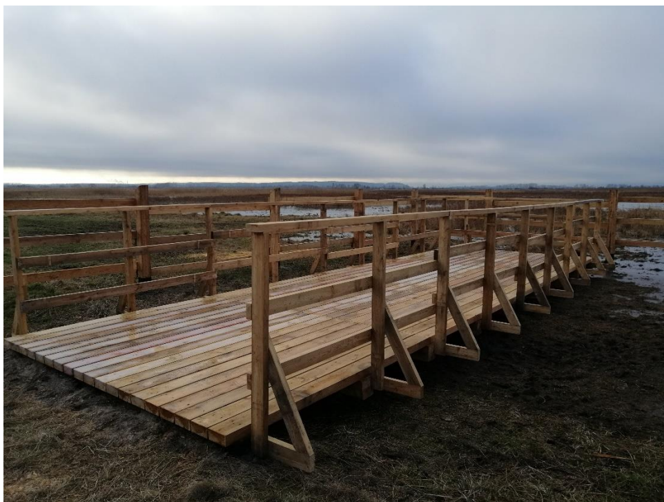
Kładka obserwacyjna (platforma drewniana) (fot 3-4)
